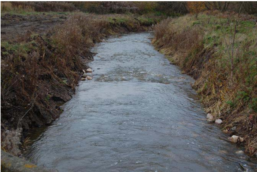
Figur 6. Bilden visar exakt samma sträcka före (ovan) och efter (under) vårt arbete. Märk väl att vattenståndet är detsamma. Vi har koncentrerat och tryckt ihop flödet med hjälp av sten och block. Mellan sten koncentrationerna har vi lagt ut lekgrus. Här kommer träd att planteras på båda sidor så att framtida rensningar undviks.
