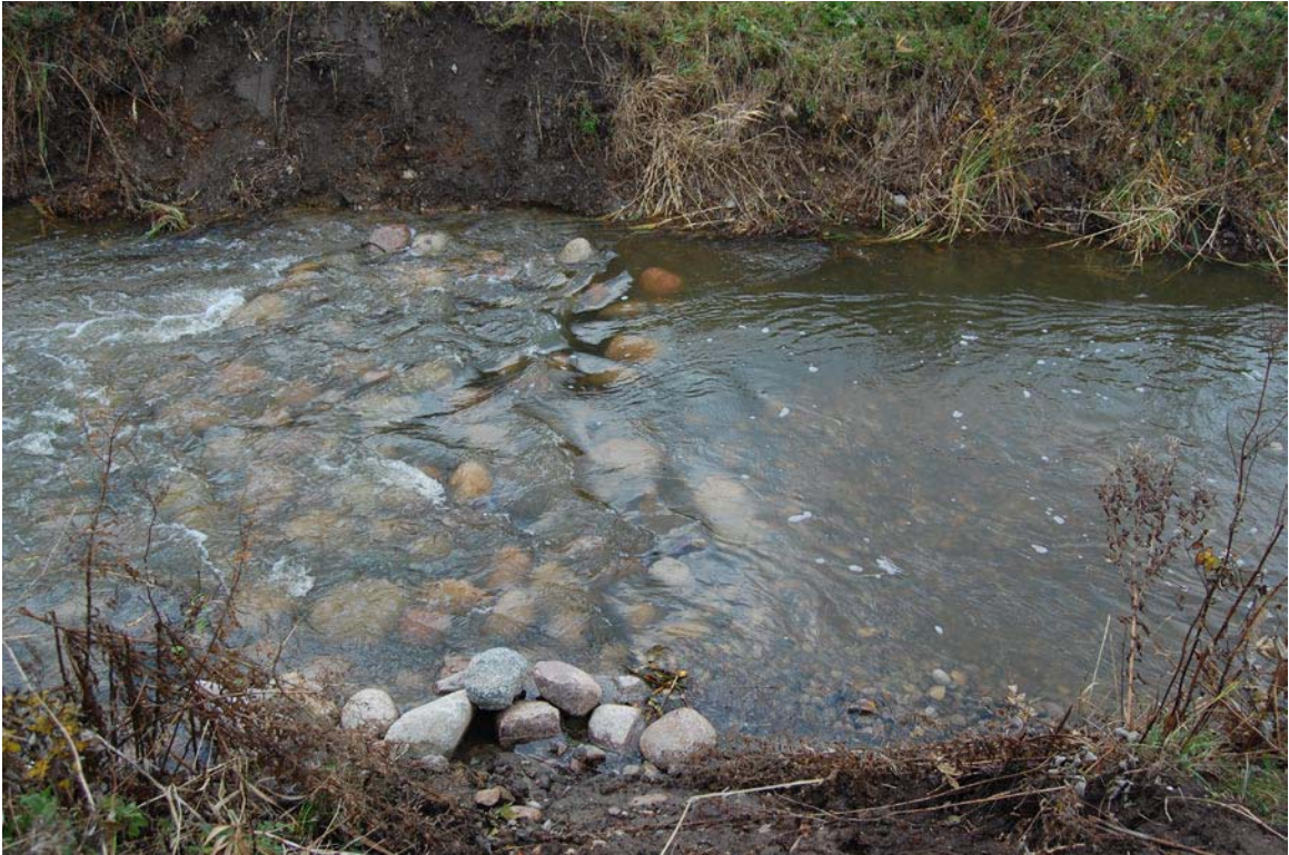
Figur 4. Bilden visar hur stenen vi lagt ut koncentrerar flödet och höjer vattenhastigheten. Uppströms stenen har vi lagt ut lekgrus. De stora stenarna ser även till att lekgrusbäddarna håller sig på plats och inte sköljs nedströms.
