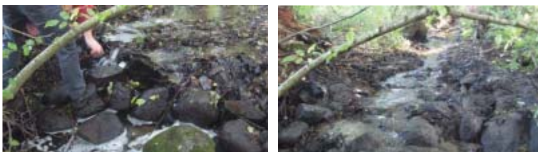
Figur 4. Tröskel av sten och byggplast i Eksholmsbäcken före och efter åtgärd
