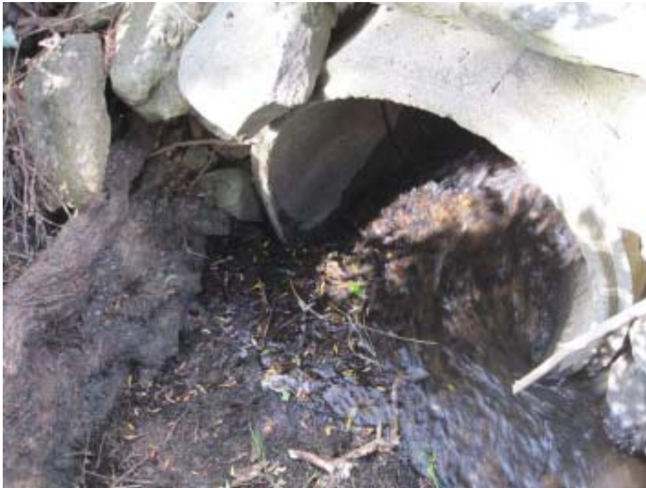
Figur 6. Inloppet i kulverten med ca 0,2 m tjockt av trädrötter i botten. Vattenhastigheten är mycket hög även vid lågt flöde.
