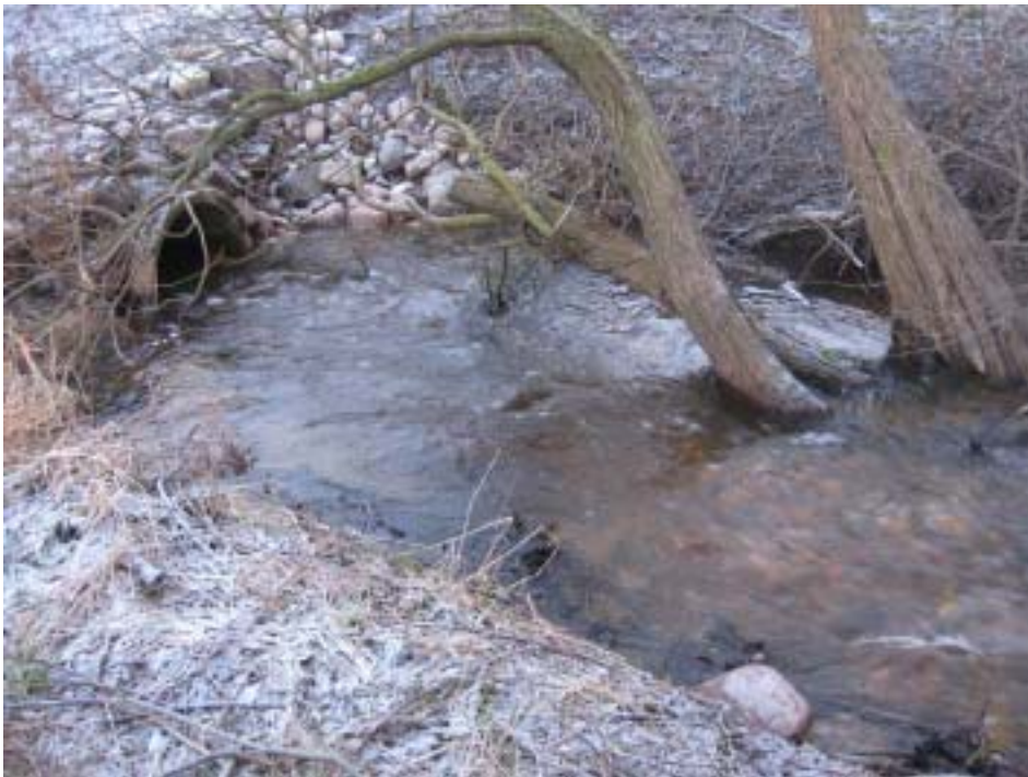
Figur 10. Nedströms kulverten vid högflöde. En djuphåla mellan tröskeln och kulverten ger fisken möjlighet att vila innan passagen
